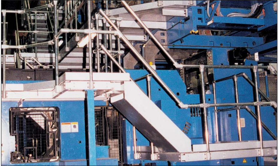
Colocación, en zonas de trabajo elevadas, de barandillas y barras intermedias reglamentarias.
